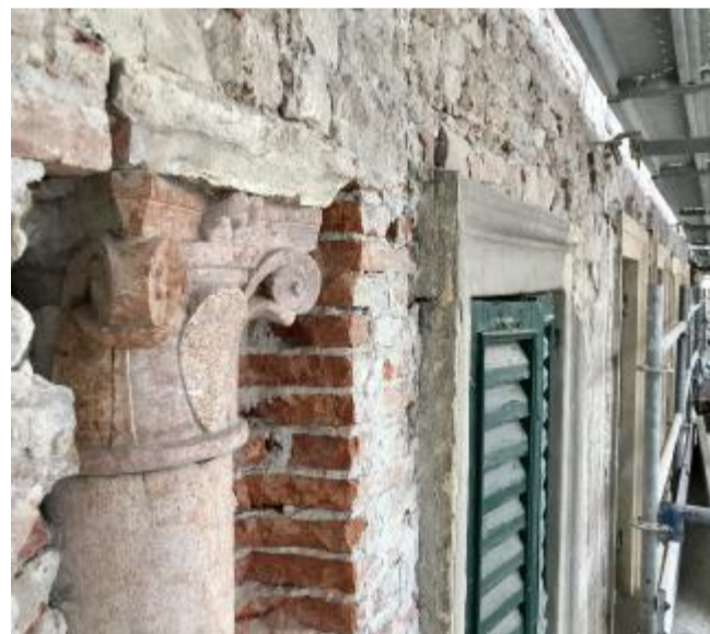
Le colonne in marmo recuperate e che resteranno a vista sulla facciata
